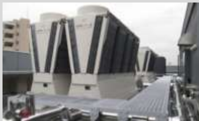
NBF高輪ビル
