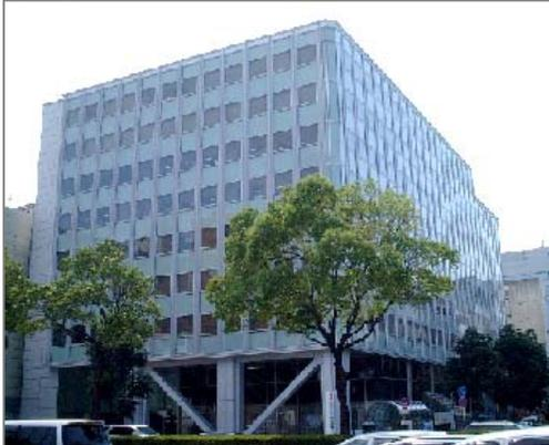
既存外壁の上にガラスカーテンウォールでカバーリングし、先進的なイメージに変更。旧耐震基準によって設計・施工された建物であったため、「耐震改修促進法」に基づく認定取得後、耐震改修工事を完了
