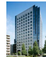
大崎MTビル
