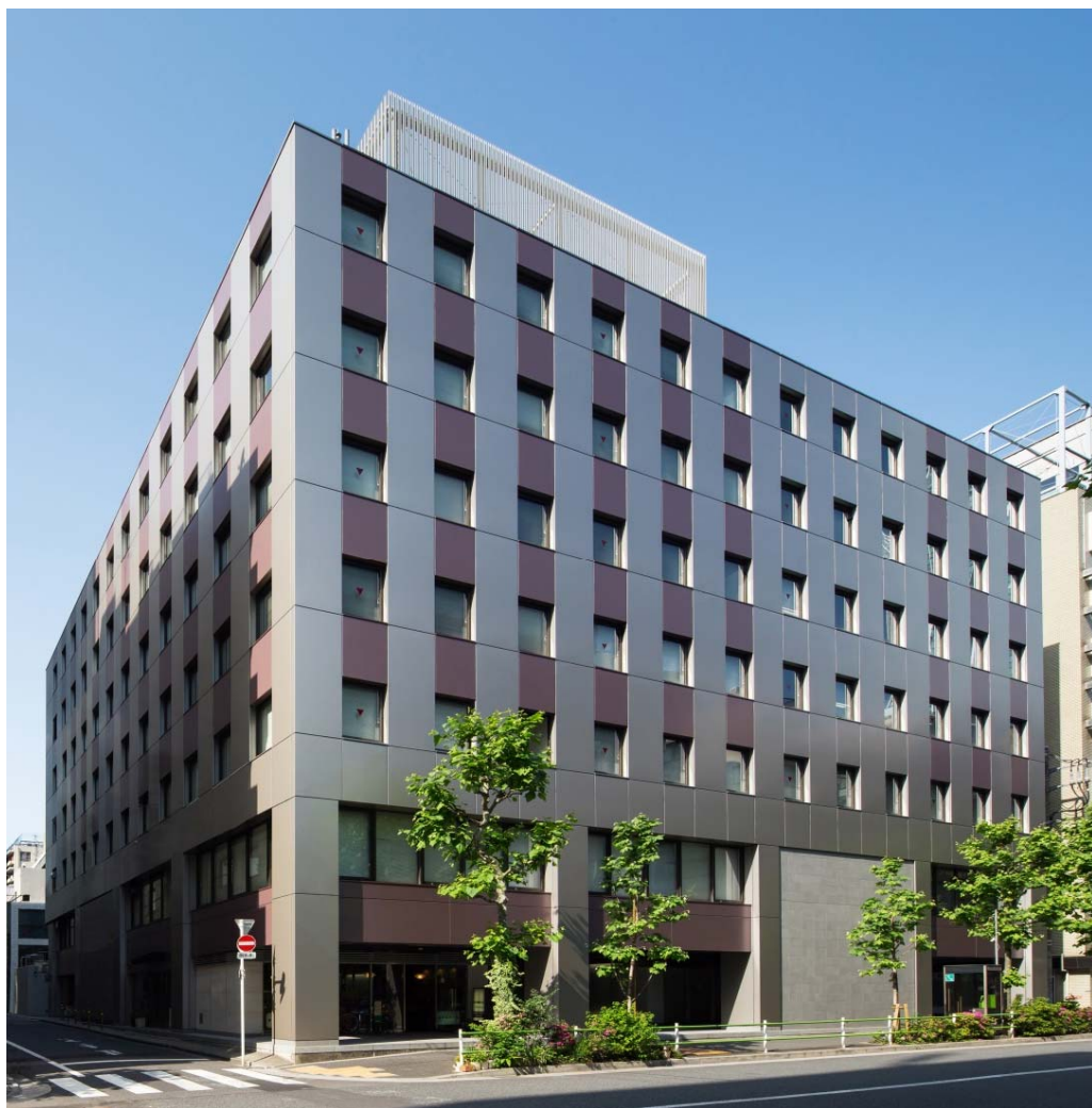
ランディック第2新橋ビル（外壁）
