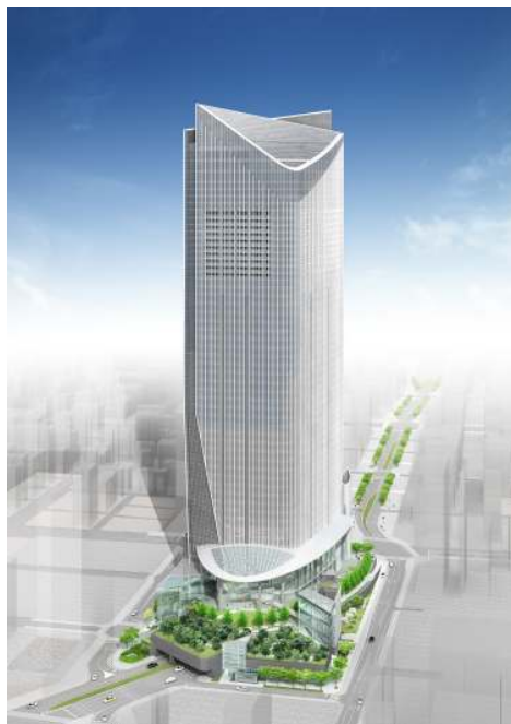
超高層棟全景(注2)
