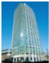
NBFプラチ ナタワー (東京都港区)
