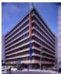
事C-4 東京建物本町ビル
