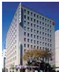
事B-3 JPR横浜日本大通ビル
