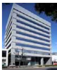
事C-19 JPR名古屋伏見ビル
