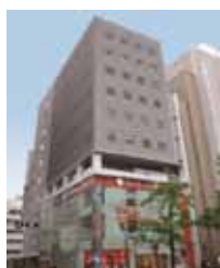
商C-3 ベネトン心斎橋ビル
