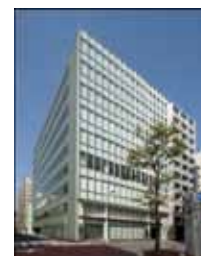
事A-20 JPR日本橋堀留ビル
