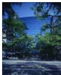
事C-18 JPR博多中央ビル
