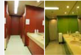
MS芝浦ビル・トイレ改修
