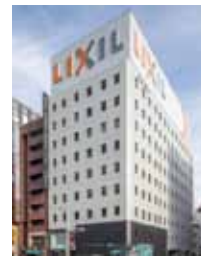
事A-19 東京建物京橋ビル
