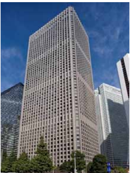
事A-14 新宿センタービル
