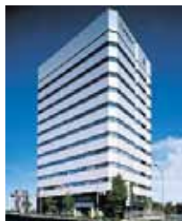
事B-5 新横浜第二センタービル
