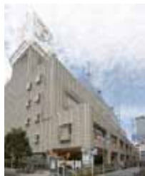
商B-4 JPR武蔵小杉ビル
