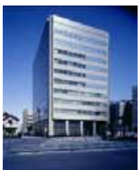
事C-12 損保ジャパン仙台ビル
