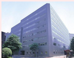
NOF日本橋本町ビル
