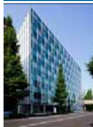
事A-21 JPR千駄ヶ谷ビル
