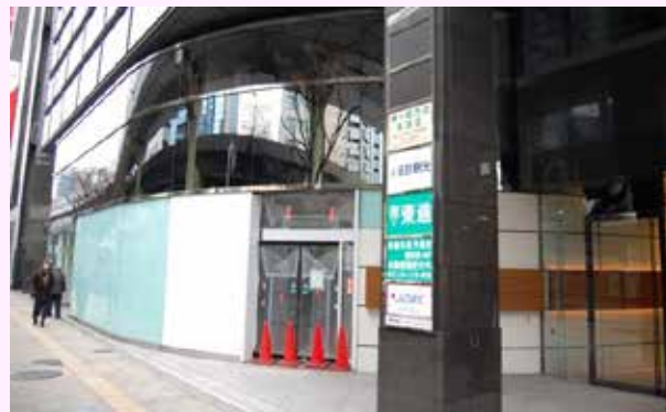
1階新規店舗（現在工事中）
