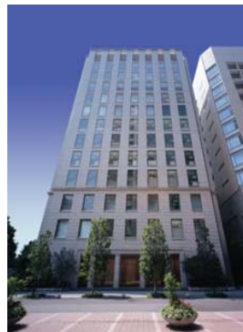
淀屋橋フレックスタワー
