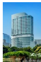
浜離宮インターシティ
