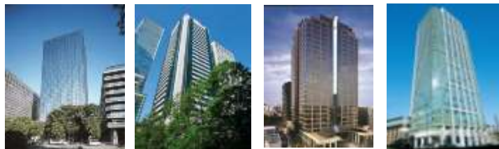
NBF日比谷ビル (東京都千代田区) 三菱重工ビル (東京都港区) 西新宿三井ビルディング (東京都新宿区) NBFプラチナタワー (東京都港区)
