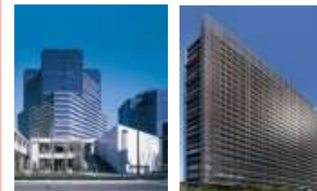
ゲートシティ大崎 (東京都品川区) NBF大崎ビル (東京都品川区)
