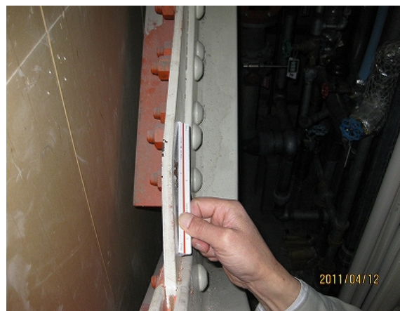
↑ 中央プレート部分に数mmの歪みが発生
