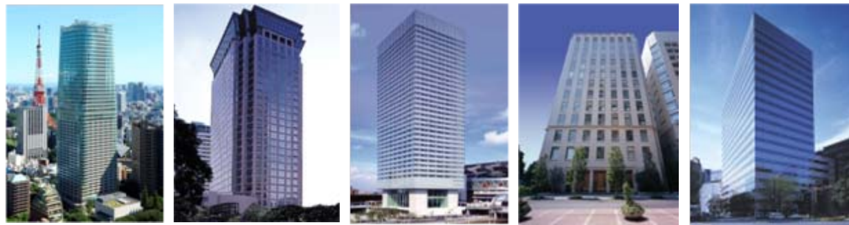
アークヒルズ 仙石山森タワー スフィアタワー 天王洲 明治安田生命 さいたま新都心ビル 淀屋橋フレックスタワー 近鉄新名古屋ビル
