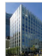
日土地虎ノ門ビル
