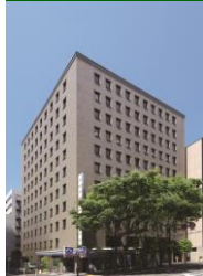
事B-3 JPR横浜日本大通ビル
