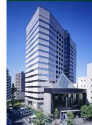
事B-6 川口センタービル
