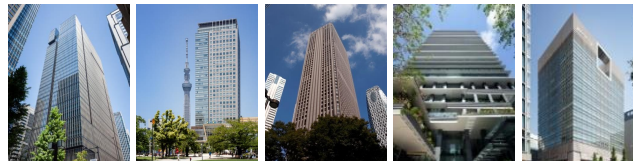
大手町タワー（底地） オリナスタワー 新宿センタービル 東京スクエアガーデン 兼松ビル
