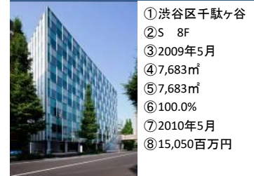
事A-21 JPR千駄ヶ谷ビル
