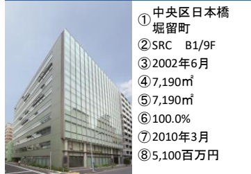
事A-20 JPR日本橋堀留ビル
