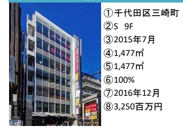
商A-7 FUNDES水道橋
