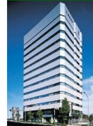
事B-5 新横浜第二センタービル
