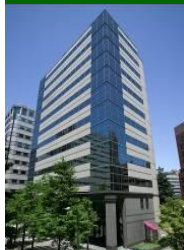
事B-8 立川ビジネスセンタービル
