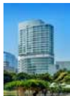
浜離宮インターシティ
