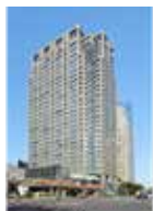
日石横浜ビル
