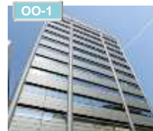
セントラル新大阪ビル
