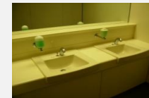
新宿センタービル・トイレ改修
