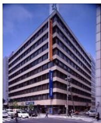
事C-4 東京建物本町ビル
