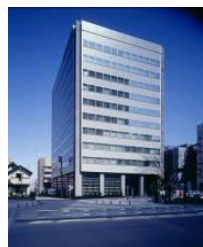
事C-12 損保ジャパン仙台ビル
