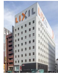
事A-19 東京建物京橋ビル
