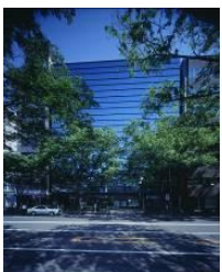
事C-18 JPR博多中央ビル
