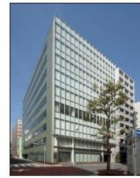
事A-20 JPR日本橋堀留ビル
