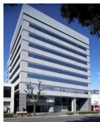
事C-19 JPR名古屋伏見ビル
