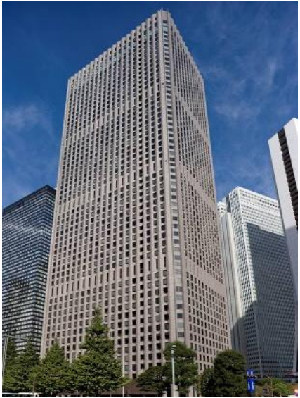
事A-14 新宿センタービル
