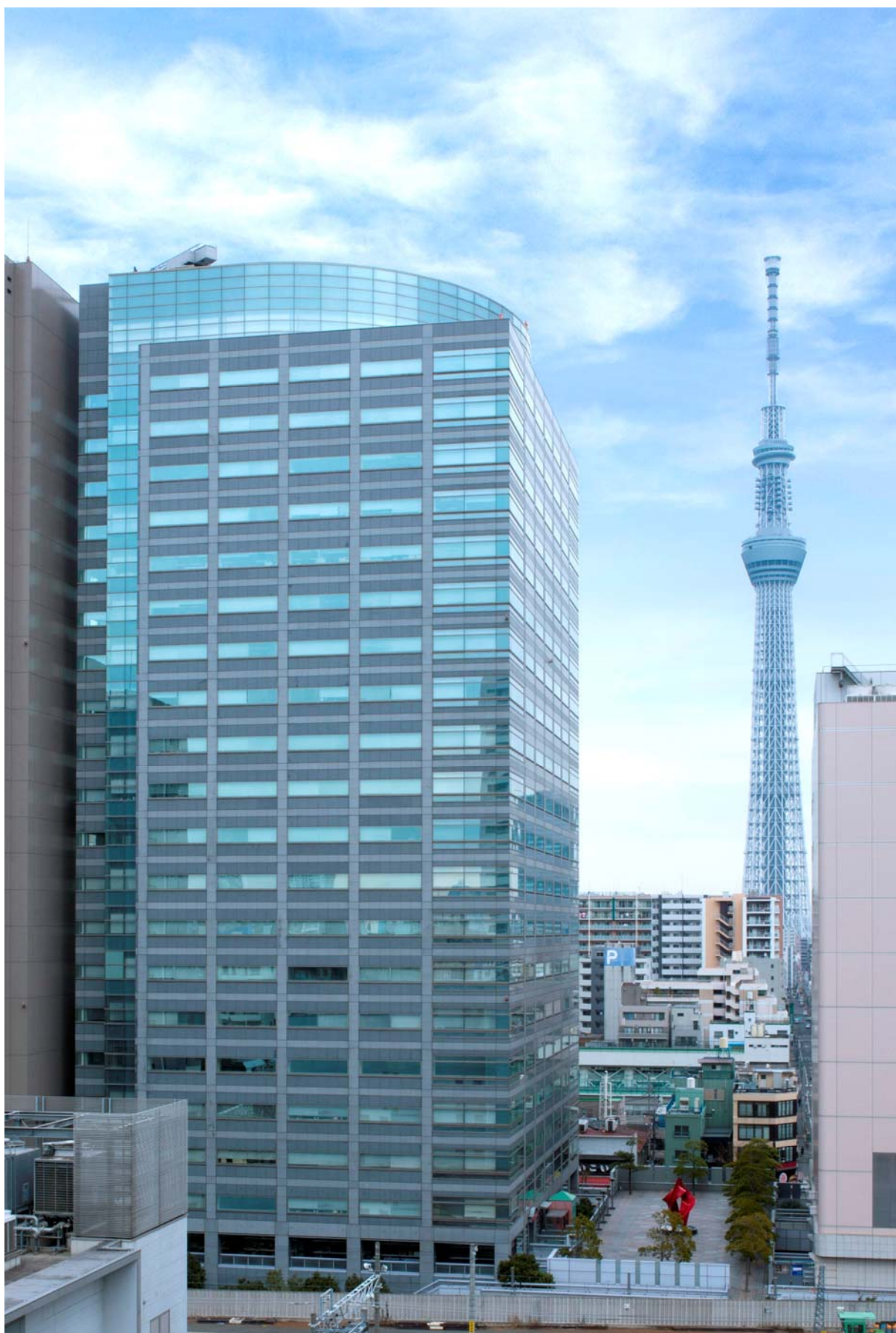
<参考資料1>アルカセントラル 外観写真
