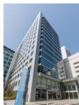
A-52 大宮センタービル
