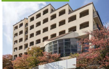
ロングライフ神戸青谷 (兵庫県神戸市)
