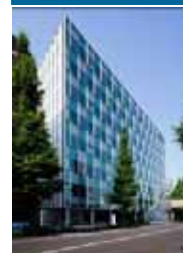
事A-21 JPR千駄ヶ谷ビル
