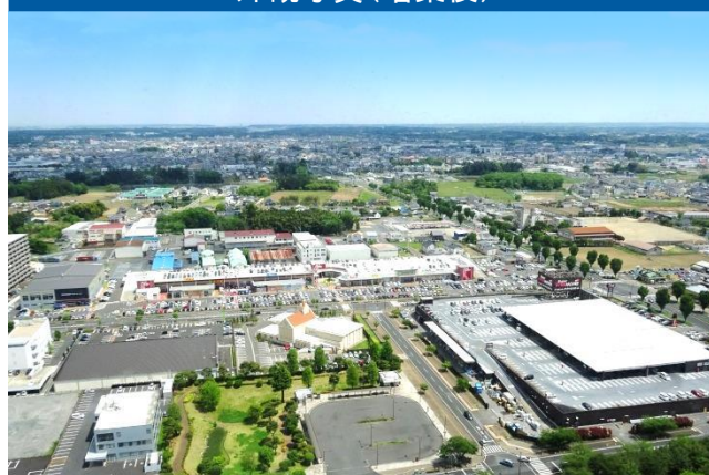
外観写真(増築後)
