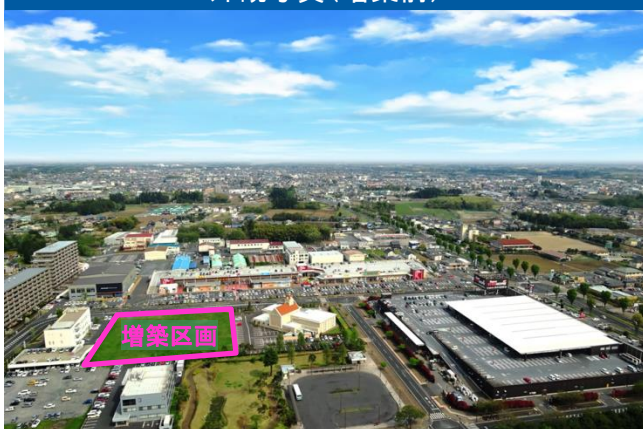
外観写真(増築前)
