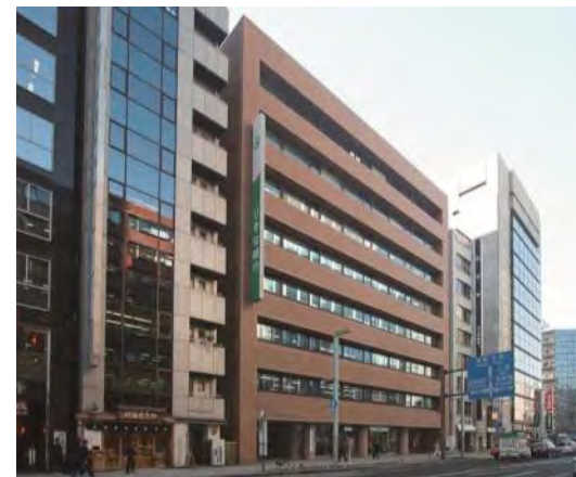
NBF日本橋室町センタービル (東京都中央区)
