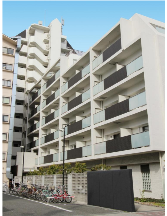
(南東側より撮影)
