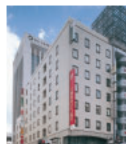
I-12 GINZA SANWA BUILDING 銀座三和ビル
