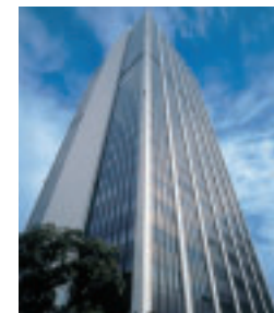
I-28 SHIBUYA CROSS TOWER 渋谷クロスタワー
