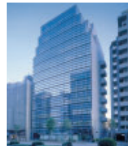
I-21 TAKANAWADAI BUILDING 高輪台ビルディング
