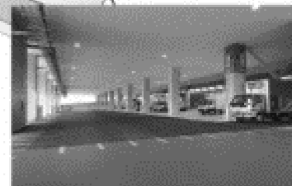
■ 1階トラックヤード
