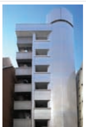
⑦ KDX神田三崎町ビル KDX Kanda Misaki-cho Building
