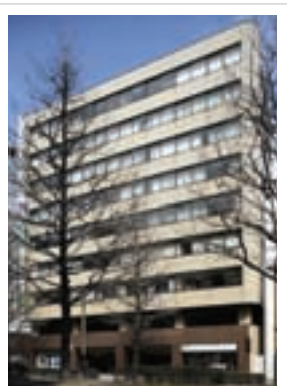
A-44 KDX仙台ビル KDX Sendai Building
