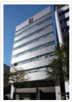
A-49 日総第17ビル Nissou Dai-17 Building
