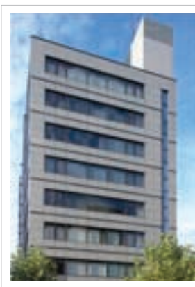
A-50 池尻大橋ビルディング Ikejiri-Oohashi Building
