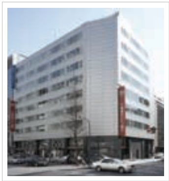
A-40 虎ノ門東洋ビル
