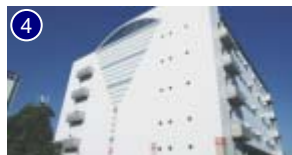
M-4 東京新木場物流センター
