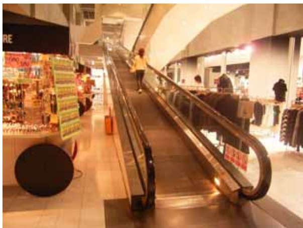
キャナルシティ博多に設置されているオートスロープ
