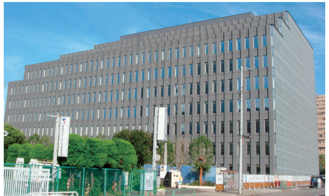
㉖ (仮称)豊洲5丁目ビル
