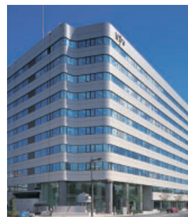
43 NBFユニックスビル
