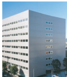
19 NBF高輪ビル
