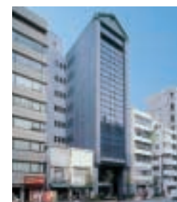
I-9 KODENMACHO SHIN-NIHONBASHI BUILDING 小伝馬町新日本橋ビルディング
