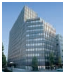
I-4 MITSUBISHI SOKEN BUILDING 三菱総合研究所ビルディング
