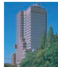
Ⅲ-12 NHK HIROSHIMA BROADCASTING CENTER BUILDING NHK広島放送センタービル
