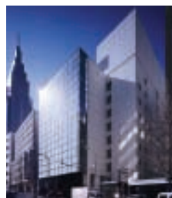
I-22 NIPPON BRUNSWICK BUILDING 日本ブランスウィックビル
