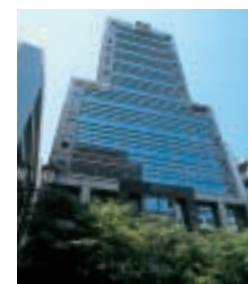
Ⅲ-14 TENJIN CRYSTAL BUILDING 天神クリスタルビル
