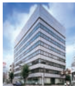
Ⅲ-7 NAGOYA MISONO BUILDING 名古屋御園ビル
