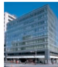
I-7 SANNO GRAND BUILDING 山王グランドビル
