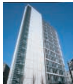
I-23 YOYOGI 1CHOME BUILDING 代々木1丁目ビル
