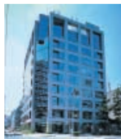
I-3 KANDABASHI PARK BUILDING 神田橋パークビルディング
