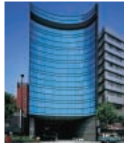
I-31 IKEBUKURO YS BUILDING 池袋YSビル
