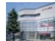
第2東急鷺沼ビル
