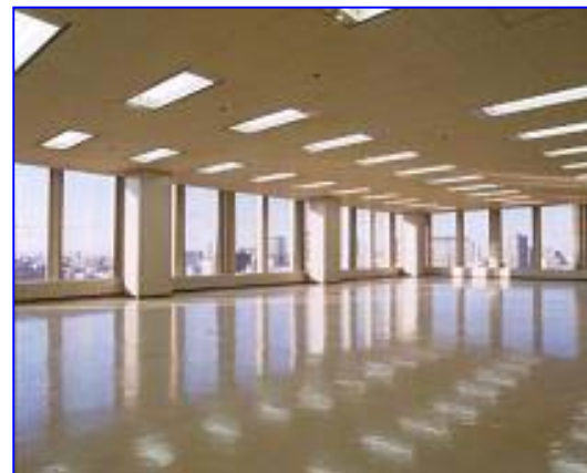
リニューアル工事前のオフィススペース
