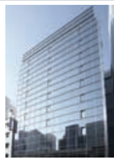
A-33 KDX御徒町ビル KDX Okachimachi Building
