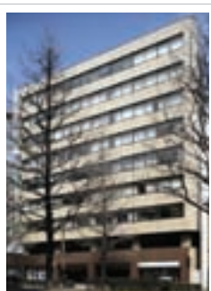
A-44 KDX仙台ビル KDX Sendai Building
