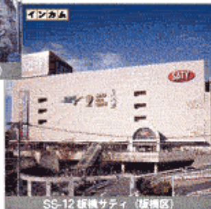
SS-12 板橋サティ (板橋区)
