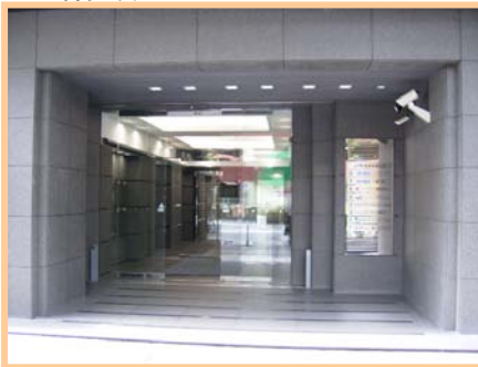
明るくかつ省エネ照明のエントランスへ改修
