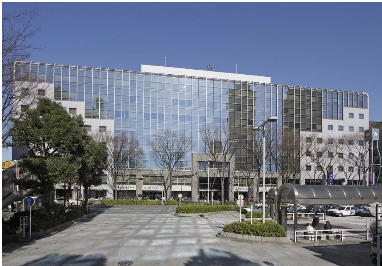
(参考) 武蔵小杉STMビル外観写真
