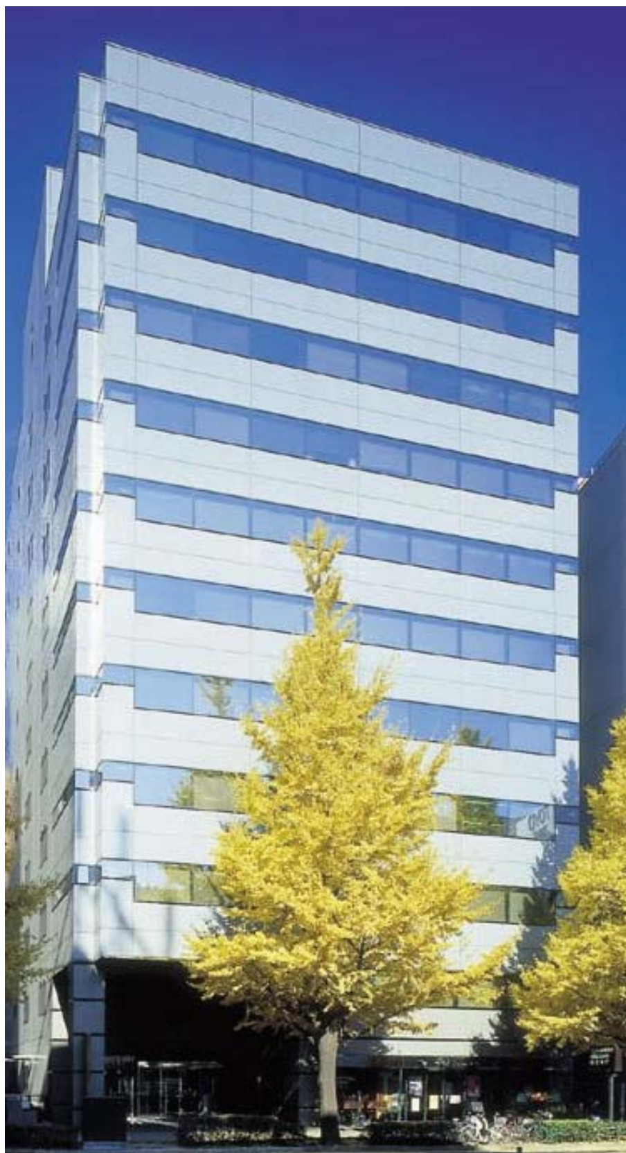
(参考) 仙台北町ホンマビルディング外観写真
