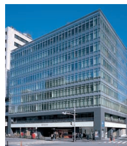
I-8 SANNO GRAND BUILDING 山王グランドビル
