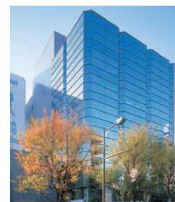
Ⅲ-15 TOSEI TENJIN BUILDING 東晴天神ビルディング
