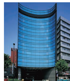
I-32 IKEBUKURO YS BUILDING 池袋YSビル
