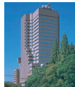
Ⅲ-14 NHK HIROSHIMA BROADCASTING CENTER BUILDING NHK広島放送センタービル
