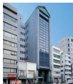
I-10 KODENMACHO SHIN-NIHONBASHI BUILDING 小伝馬町新日本橋ビルディング
