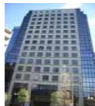
大崎MTビル
