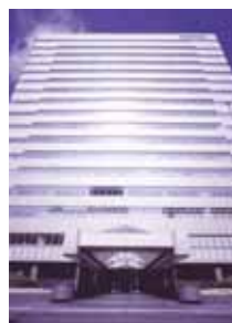
丸紅大阪 本社ビル
