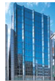
58 NBF広島立町ビル
