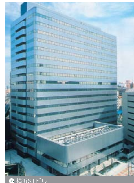
36 横浜STビル
