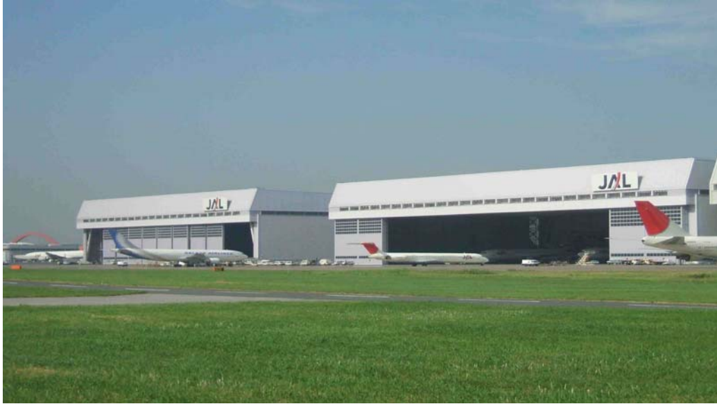
左：IIF 羽田空港メンテナンスセンター1 (M1)
