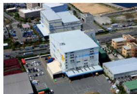
L-8 IIF 西宮 ロジスティクスセンター
