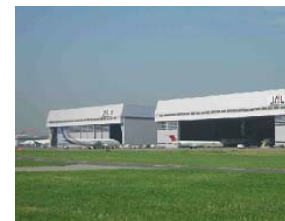
I-2 IIF 羽田空港 メンテナンスセンター
