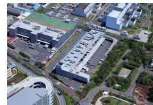
L-5 IIF 新砂 ロジスティクスセンター
