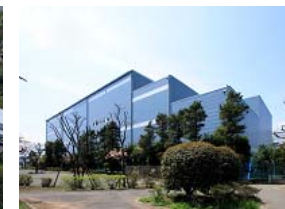
L-6 IIF 厚木 ロジスティクスセンター
