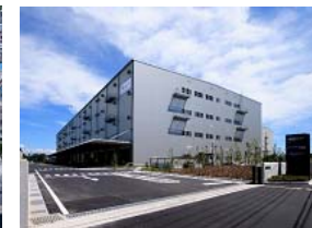
L-3 IIF 船橋 ロジスティクスセンター
