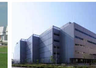
IIF 新砂 データセンター (注2)
