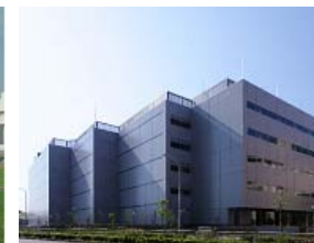
IIF 新砂 データセンター(注)
